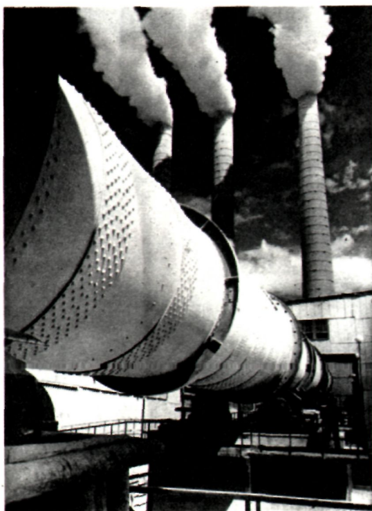
ЦЕМЕНТНЫЙ ЗАВОД. 1955 г.
